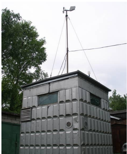
Рис. 1.2 – Общий вид павильона ПНЗ №1
